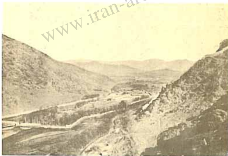
دره کابل رودبا تأسیسات صنعتی
