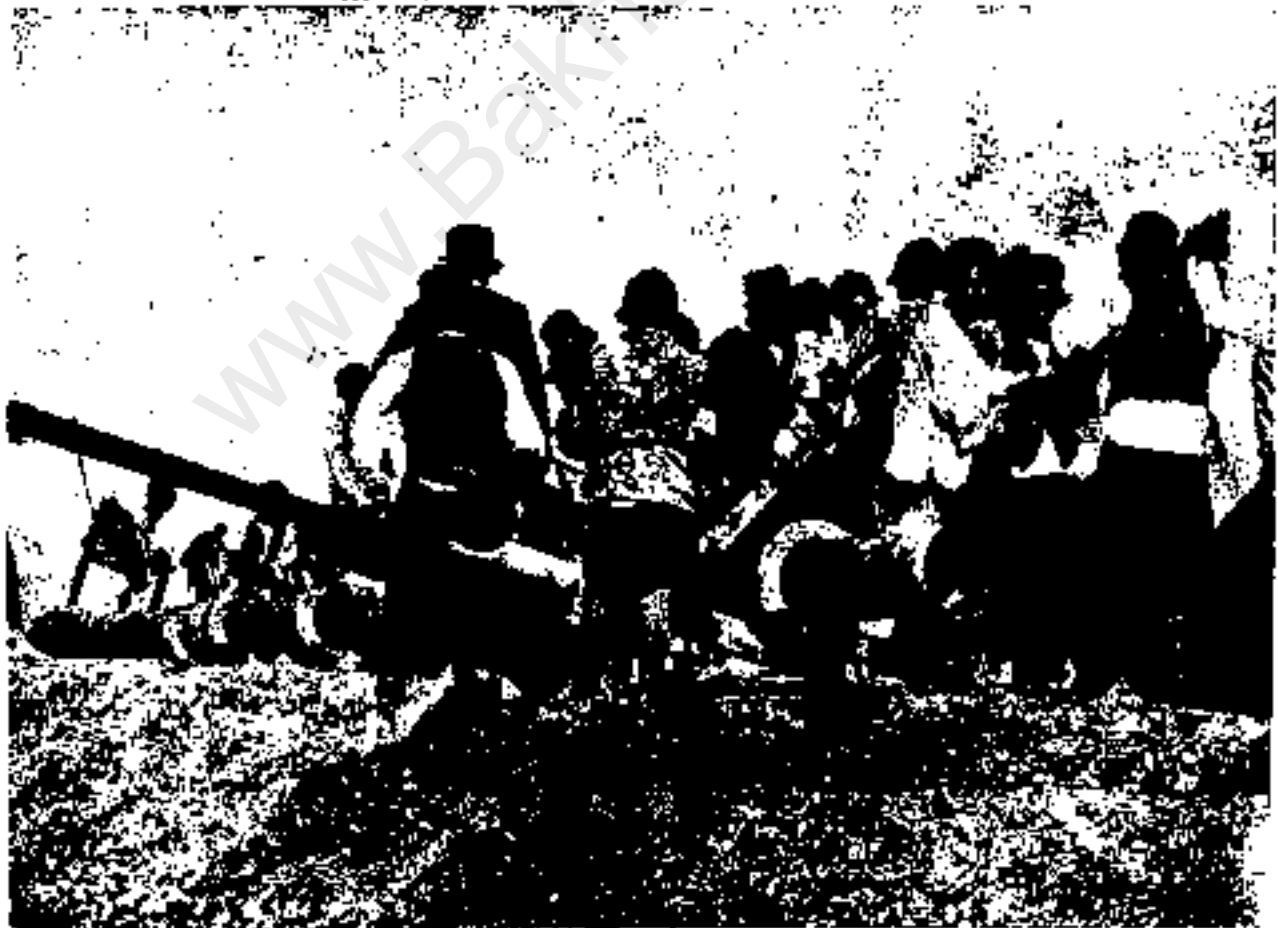
پیچ دادن و وصل کردن توله‌های نفت به سگد بگر بمنظور احداث اولس خط توله جاور میانه در سال ۱۹۰۹ میلادی
