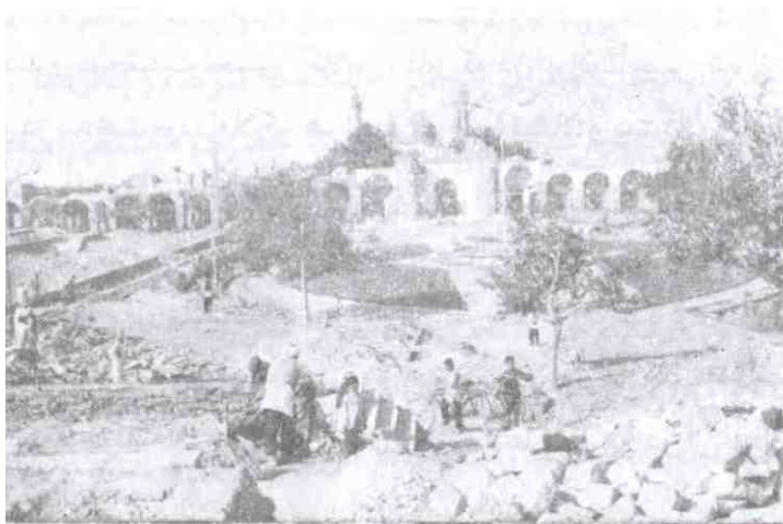
منظره‌ای دیگر از خرابی مزار پس از زمین لرزه
