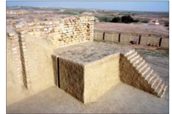
「カー・ゲル漆喰」で保護されたジググラトのテラス A terrace of the ziggurat protected with kâh-gel plaster یکی از صحنه‌های زیگورات زیر پوشش کاغذی حفاظتی
